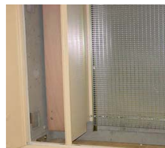
Panneaux bois + grille perforée
