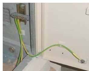
Mise à la terre des parties métalliques
